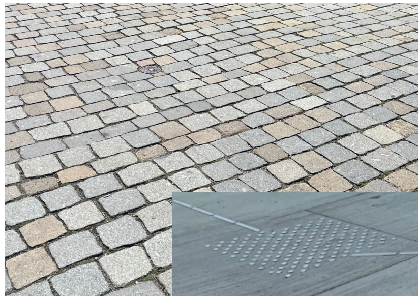
Bestandspflaster mit Leitstreifen
