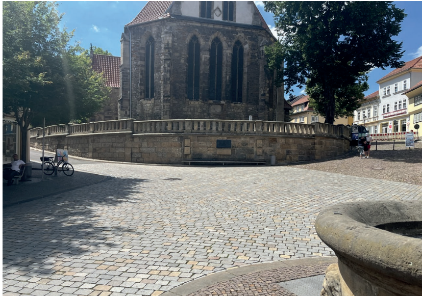
Bestandspflaster; soll weitestmöglich wieder verwendet werden
