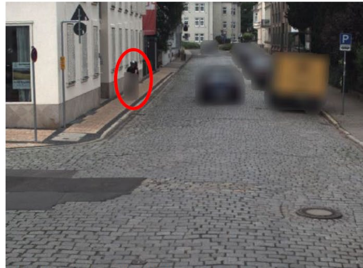
Kopfsteinpflaster und Radfahrer auf Gehweg (Quelle: Lehmann + Partner)
