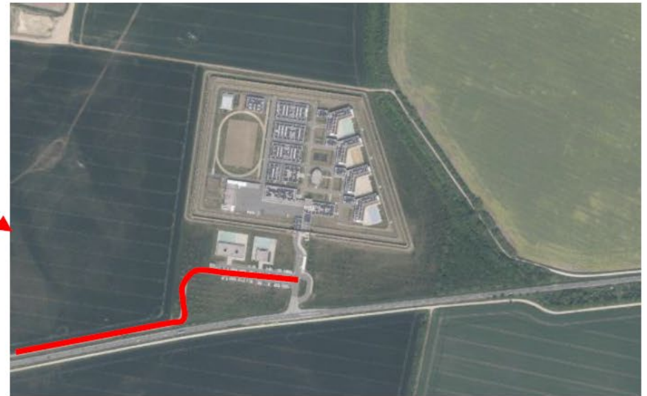
vorhandener Radweg (Quelle Luftbild: Thüringen Viewer)
